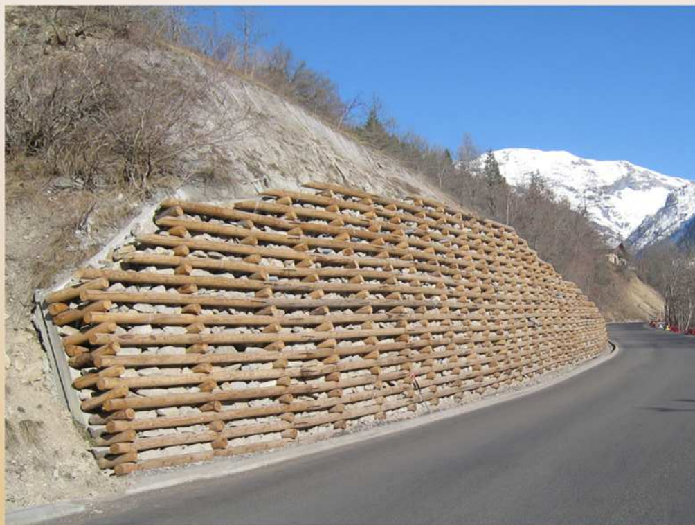
Exemples de réalisations avec habillage bois et pierres
