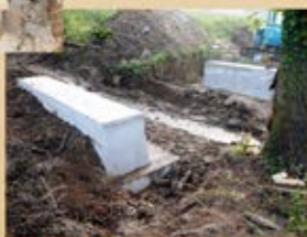
Pose sur culées béton ou bois, ancrage possible dans la roche
