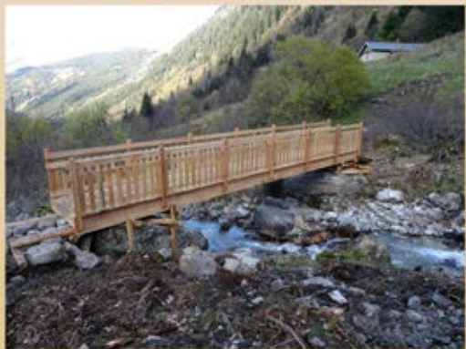
Exemple de garde-corps possibles : bois, métal, double lisses ou respectant la norme XP P98-405
