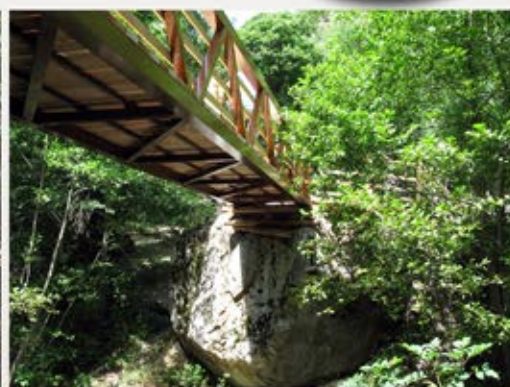
Structure en bois massif, lamellé-collé ou mixte bois/métal
