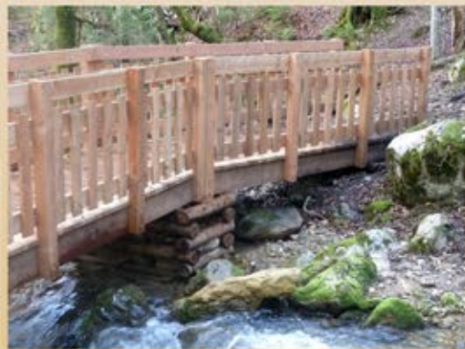
Pose sur culées béton ou bois, ancrage possible dans la roche
