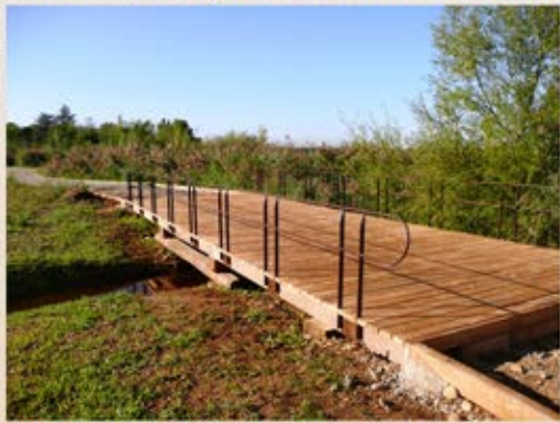
Exemple de garde-corps possibles : bois, métal, double lisses ou respectant la norme XP P98-405
