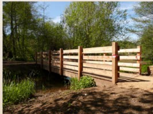
Exemple de garde-corps possibles : bois, métal, double lisses ou respectant la norme XP P98-405
