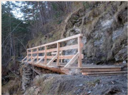
Exemple de garde-corps possibles : bois, métal, double lisses ou respectant la norme XP P98-405
