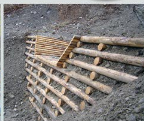
Exemples de seuils à double paroi
