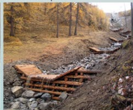
Exemples de seuils à double paroi
