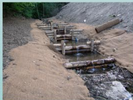
Exemples de seuils à simple paroi
