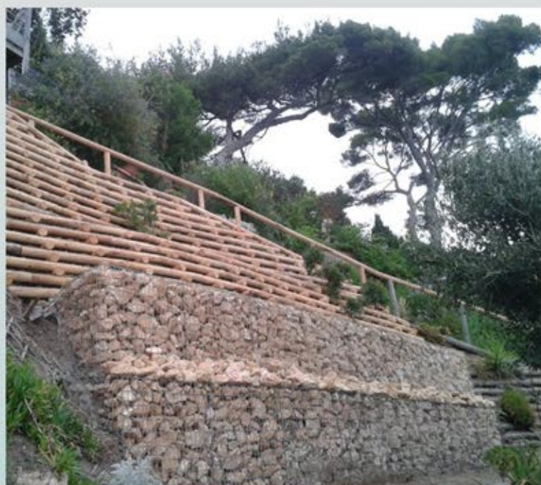
Exemples de réalisations de gabions
