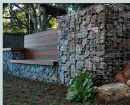
Exemples de réalisations de gabions
