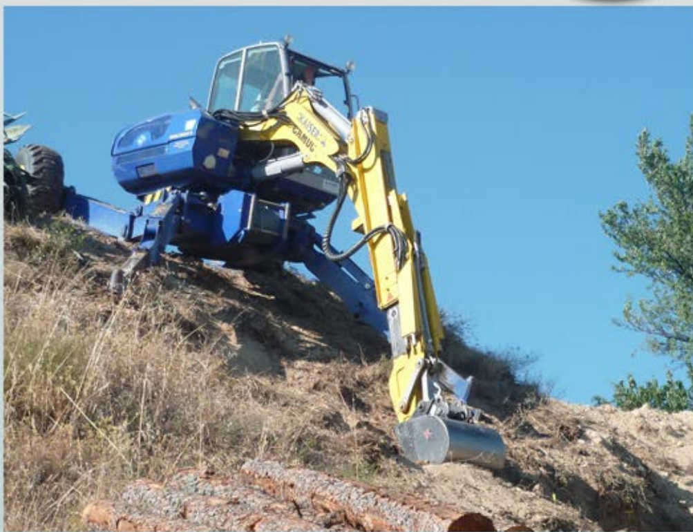
Elimination des pistes d'accès provisoires nécessaires aux travaux de terrassements
