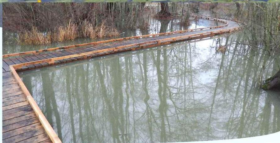
Les travaux d'aménagement à Ste Hélène du Lac consistent à réaliser un cheminement piétonnier autour du lac. La 1<sup>ère</sup> tranche de travaux, débutée fin 2016 permet la liaison entre la "promenade confort" et le "parking du Rivet" au nord-est du lac, par l'intermédiaire de cheminements sur pilotis.
